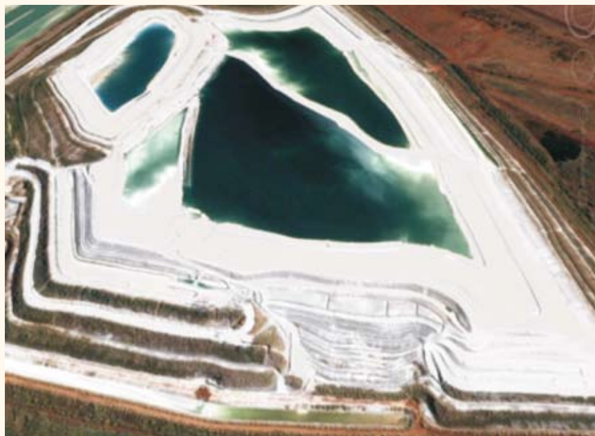
Figura 8 - Vista aérea de uma barragem de deposição de fosfogesso
